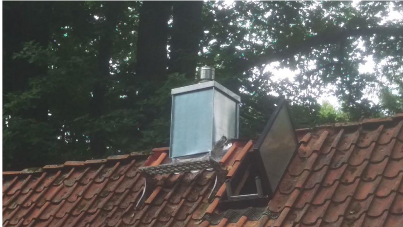
Ein neuer Schornstein auf dem Dach des Heizhauses in Hamburg-Sasel.
