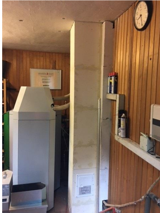
Am alten Schornstein platziert.
